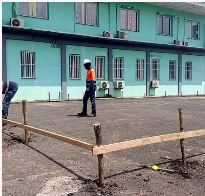
INICIO DE OBRA · 30 OCTUBRE
